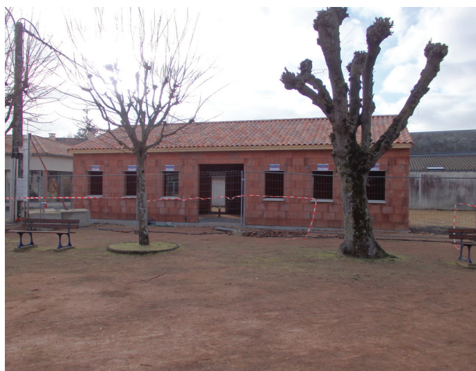
Les travaux de la future maison de santé avancent à grands pas , ouverture Printemps 2017.
