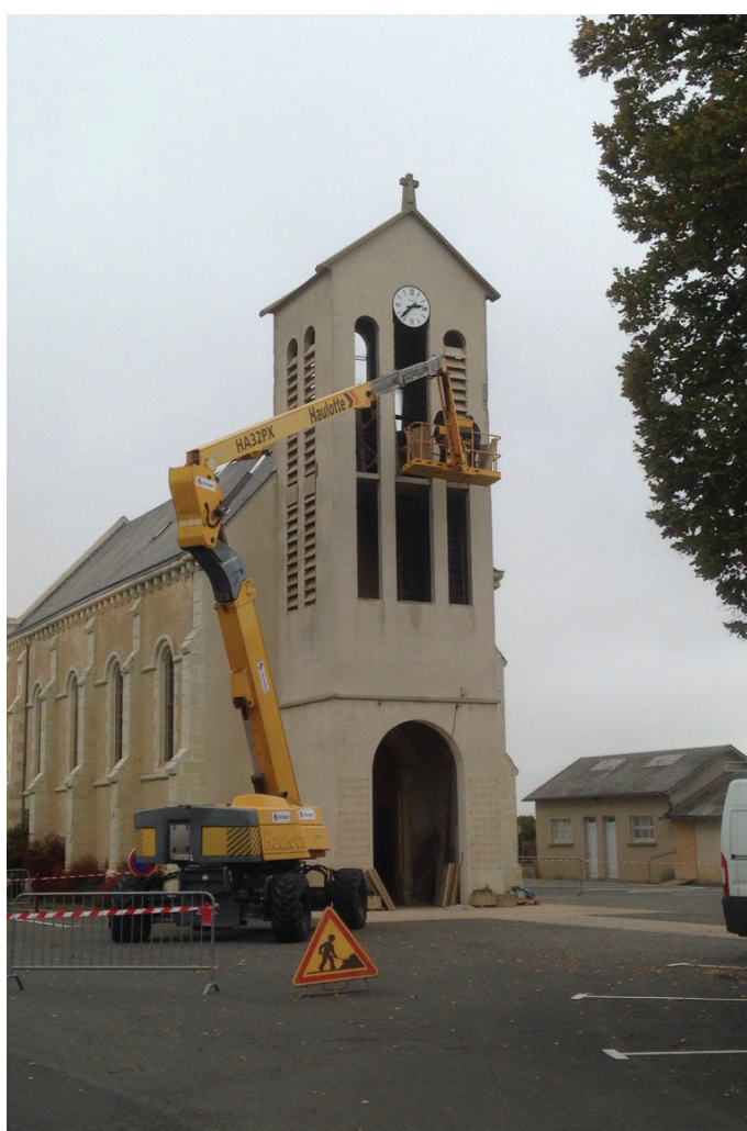
Réfection des abat sons de l'église
