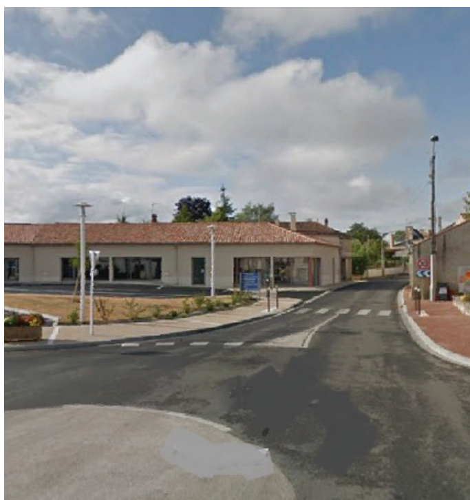
Travaux Rue de la Paix
