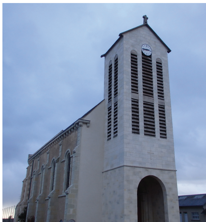
Après les travaux
