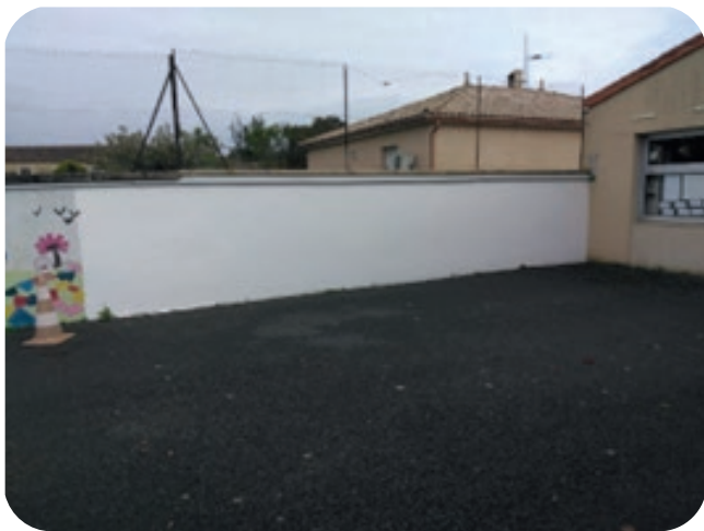
Remise en état mur de la cour d'école
