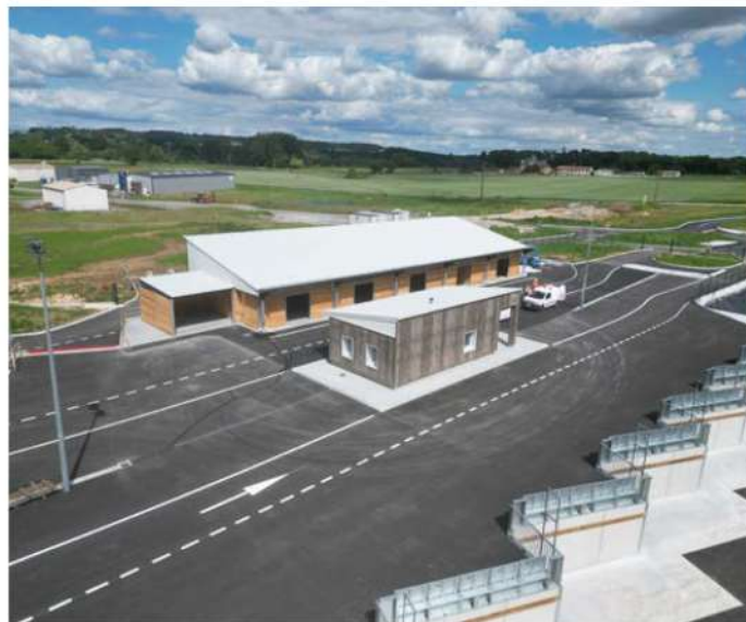
Déchetterie à Saint-Martin-la-Pallu
